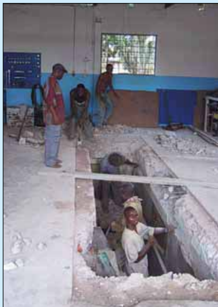
Betongbildning av smörjgropen.
